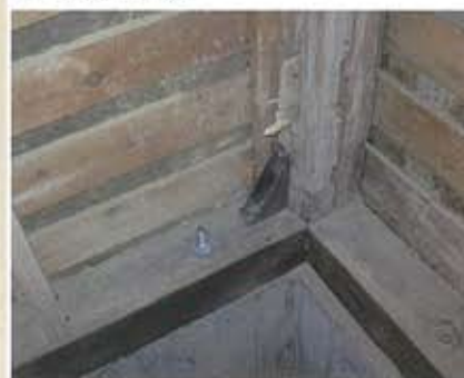
▲ 柱頭・柱脚及び筋かい端部の金物補強
