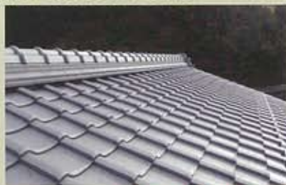
〈参考価格〉1.5～2.5万円/m 2 土葺日本瓦 → 桟葺日本瓦
