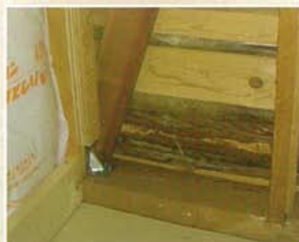
▲端部金物補強
