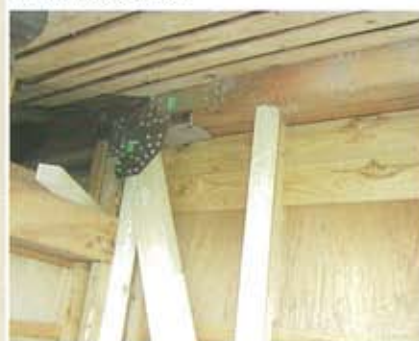
▲筋かいによる補強
