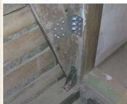
▲柱頭・柱脚及び筋かい端部を補強
